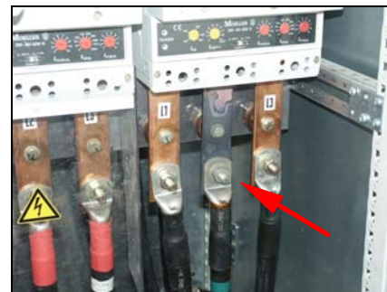
Bild 9 Leistungsschalteranschluss
