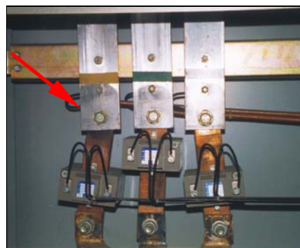
Bild 4 Originalfoto der im Infrarotbild dargestellten Schwachstelle aus dem Jahre 1997. An dem Aluminium, dem Kupfer oder auch den Schrauben ist keine Erwärmung zu erkennen.
