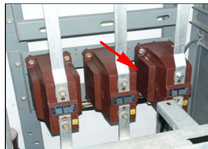
Bild 12 defekter 20 kV Wandler
