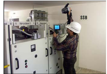
Bild 2 getrennter Aufbau von Monitor und IR-Kamera
