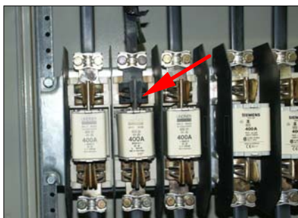
Bild 8 NH - Sicherung
